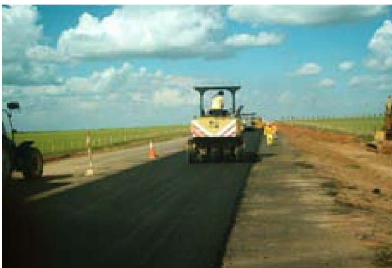
Fotografía 7: PUERTO LOPEZ- PUERTO GAITAN. Vía en mejoramiento.
