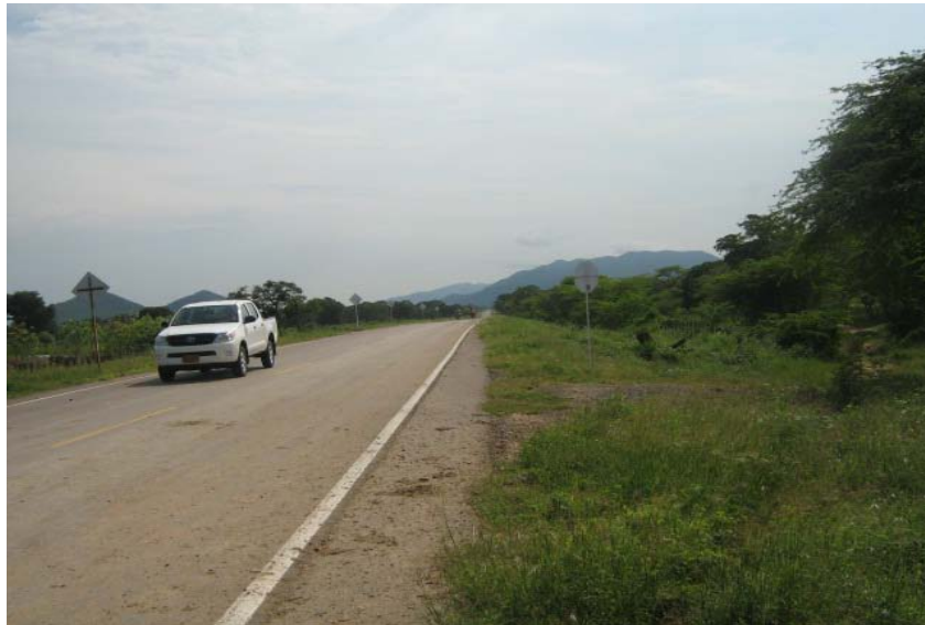
Fotografía 4: San Juan del Cesar- Badillo. Vía mejorada.
