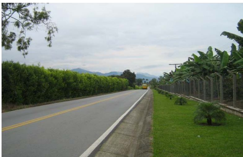
Fotografía 8: LA ESPAÑOLA- BARRAGAN-GENOVA. Vía mejorada.
