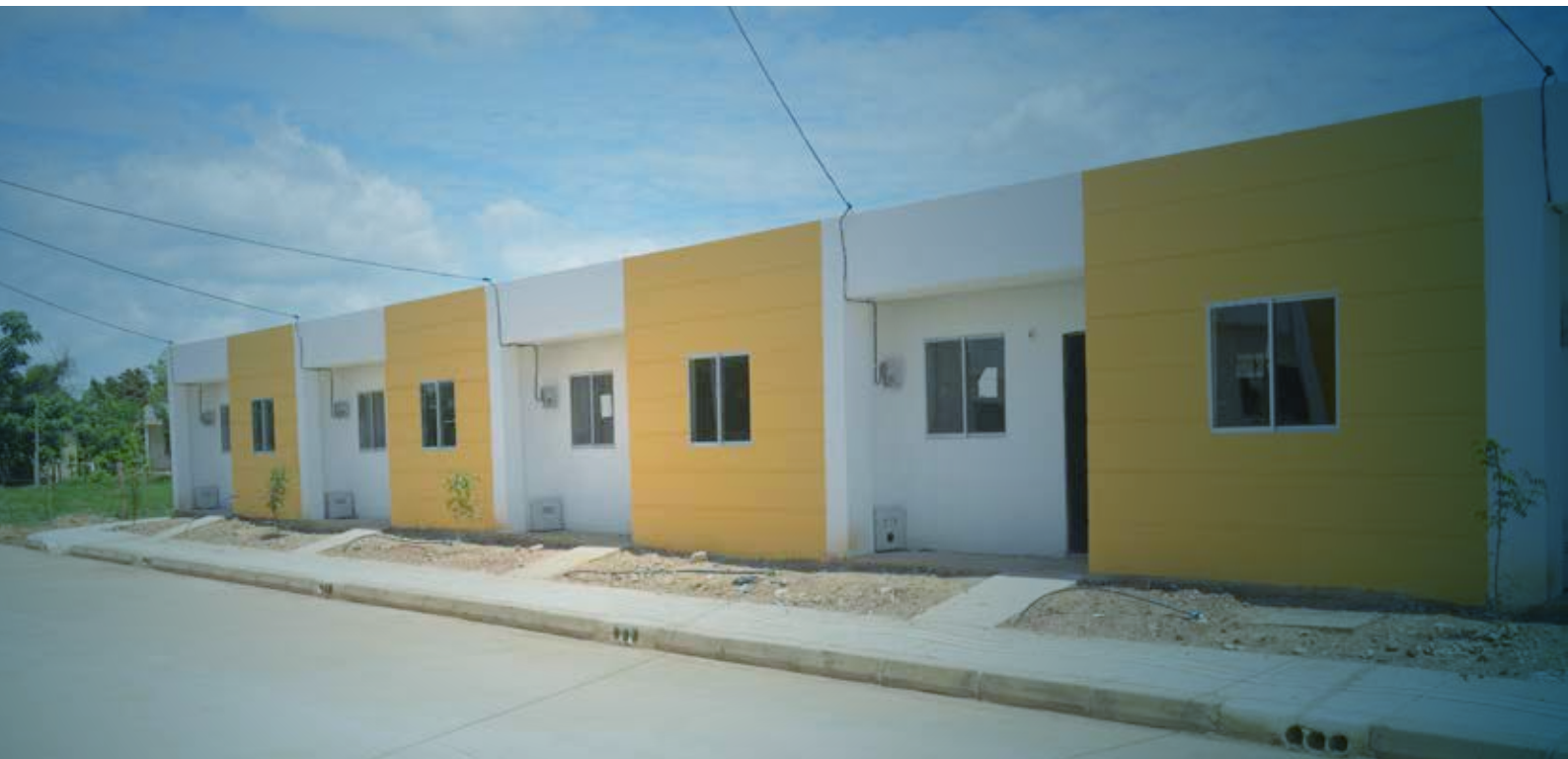
Viviendas Urbanización la Mojana, zona 2, San Benito Abad (Sucre) Foto: Comunicadores A Fondo /Fondo Adaptación
